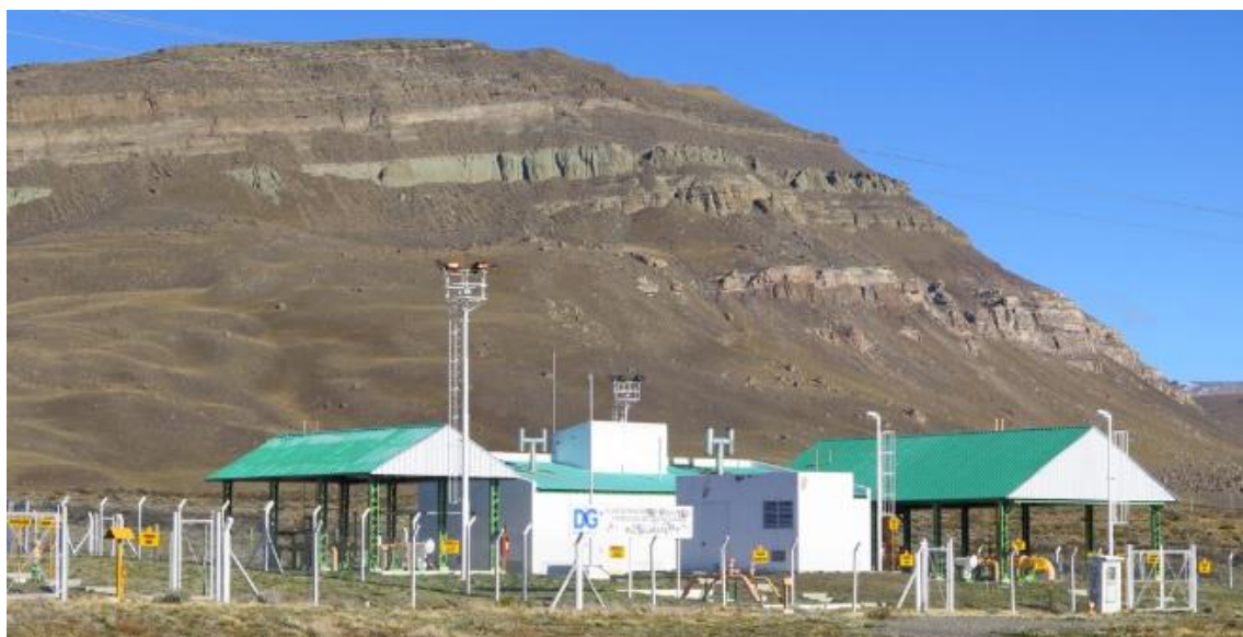
Figura -74. Planta de gas, Distrigas, El Calafate
