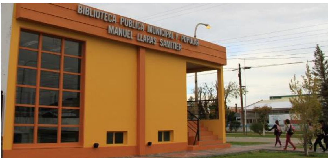
Figura -206. Biblioteca Municipal, Puerto Santa Cruz
