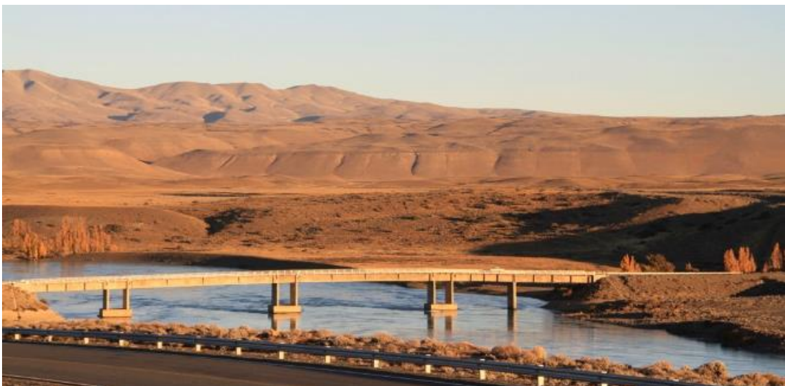
Figura -231. Puente Charles Fuhr sobre RN40
