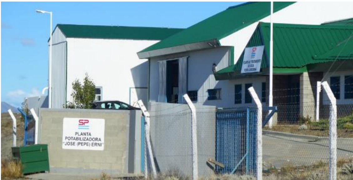
Figura -73. Planta potabilizadora de agua de SP, El Calafate
