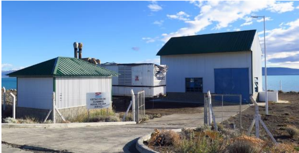
Figura -72. Estación de bombeo de agua de SP, El Calafate
