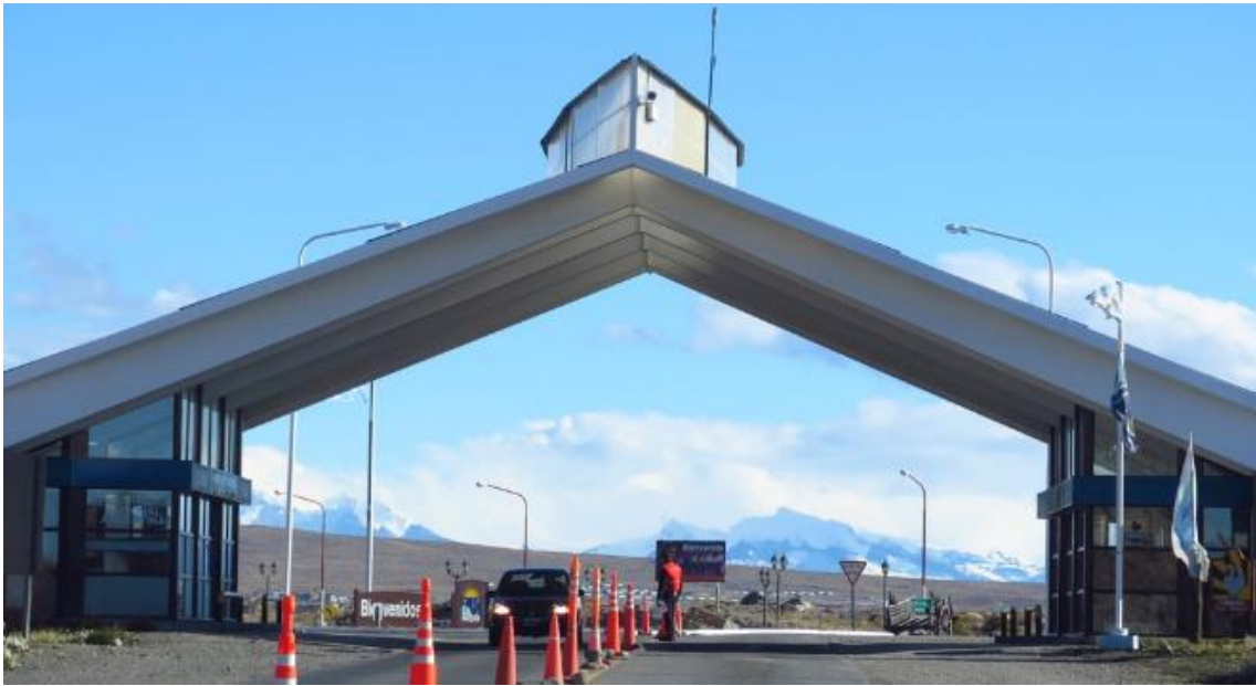
Figura -84. Puesto de Gendarmería y de la Policía Provincial en acceso a El Calafate, Ruta N° 11
