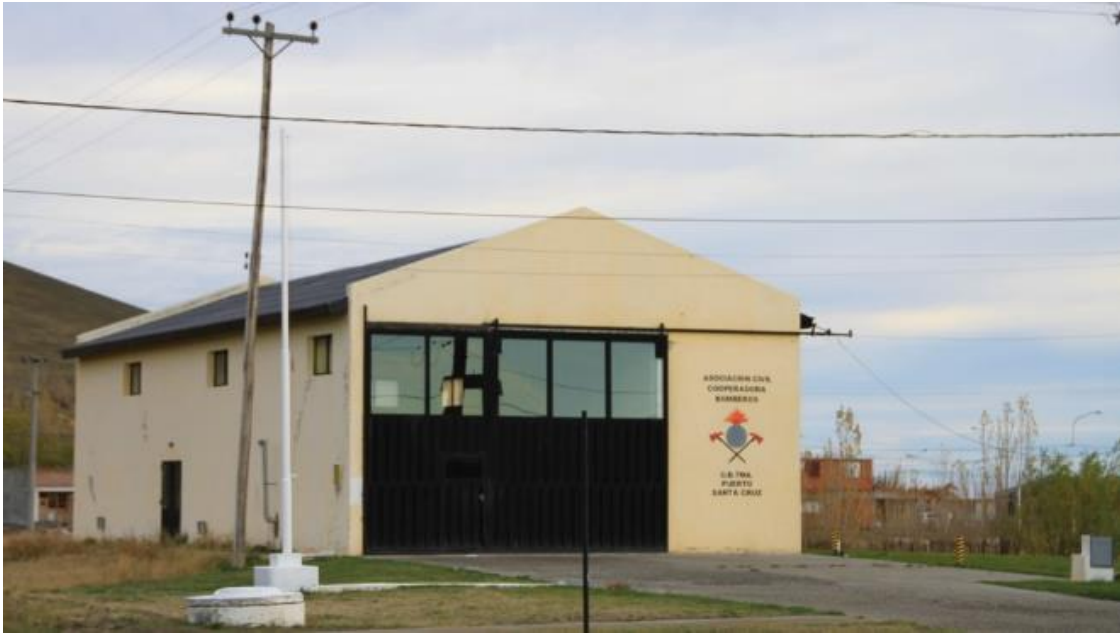
Figura -196. Cuartel de Bomberos, Puerto Santa Cruz
