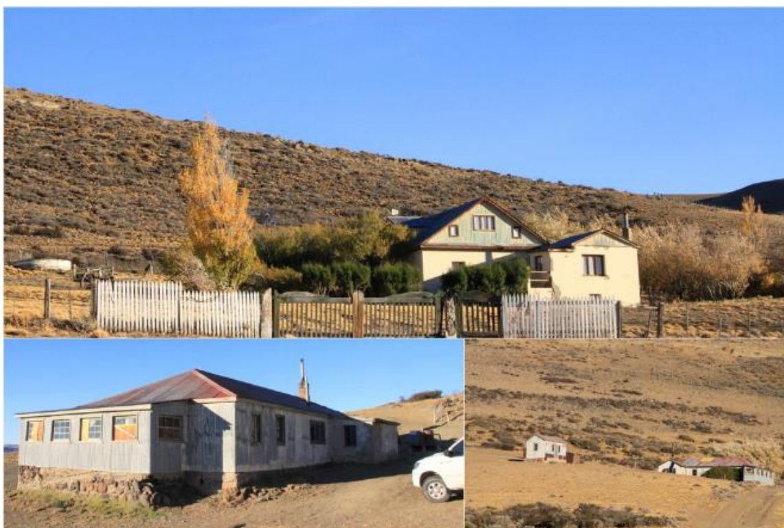
Figura -344. Infraestructura de vivienda, Ea. Rosita
