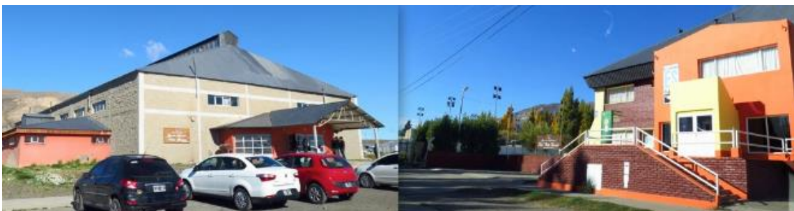
Figura -87. Gimnasio Municipal “Palos Gruesos” y Gimnasio Municipal “Pablo Palito Cherbukov”
