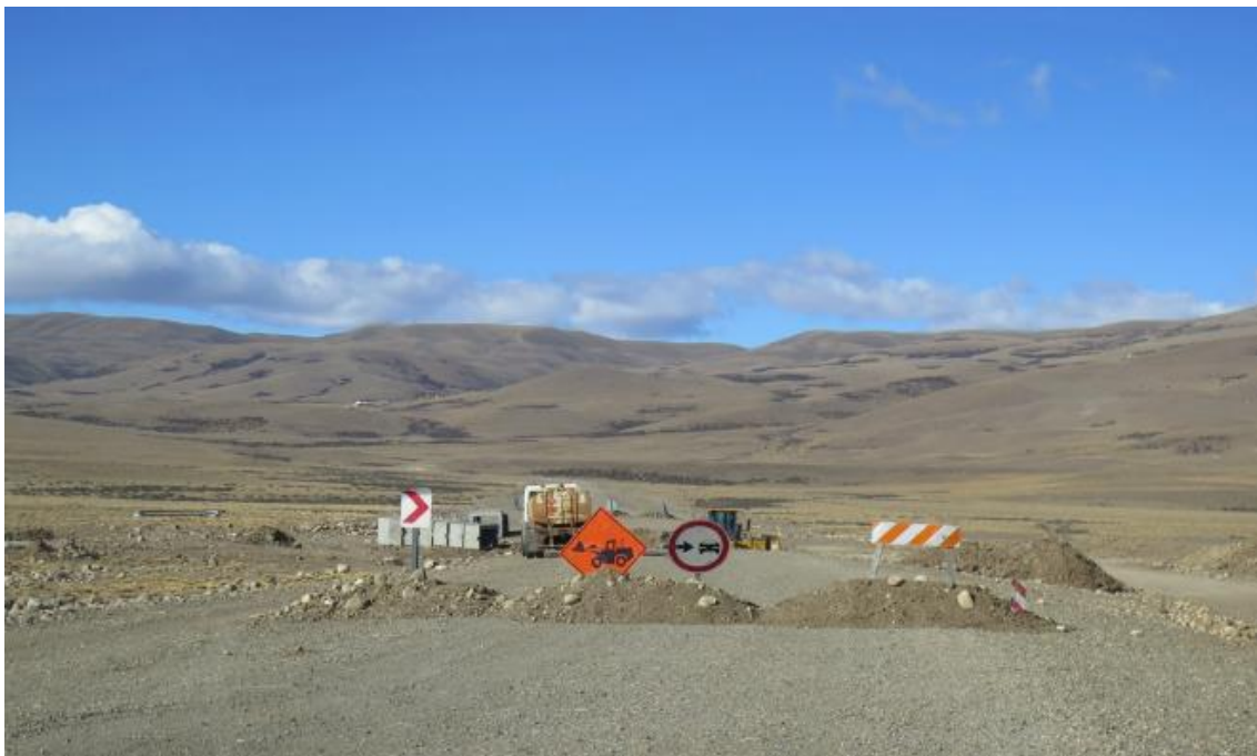
Figura -107. Trabajos sobre RP N° 9, AID del proyecto
