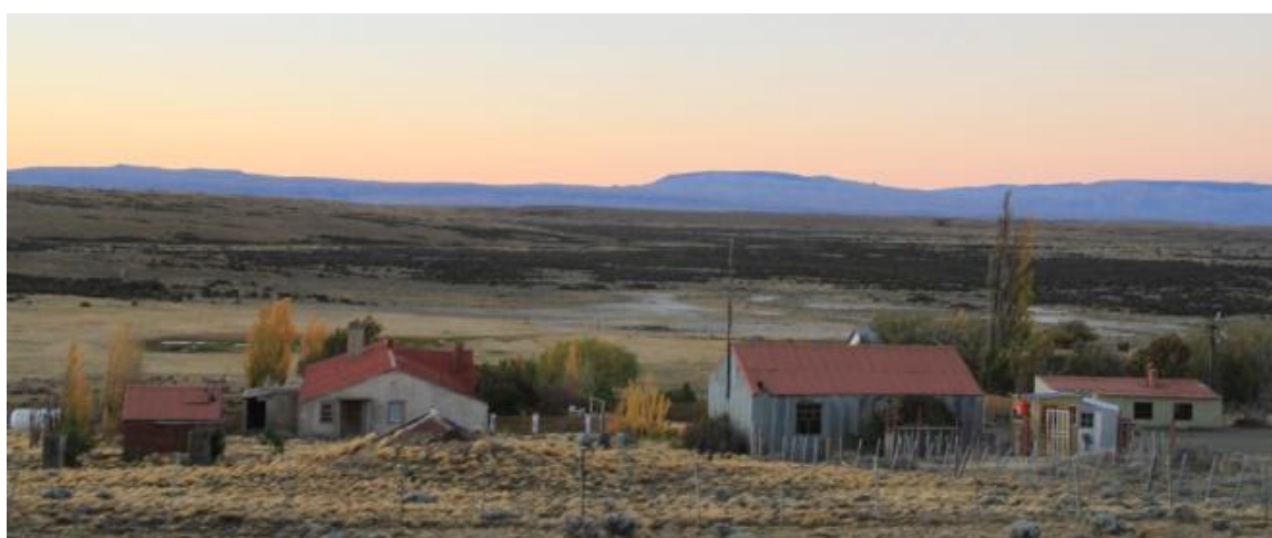
Figura -374. Infraestructura productiva y de vivienda, Ea. Bon Accord
