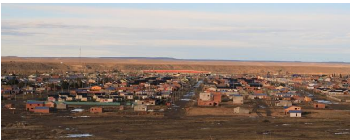
Figura -141. Expansión de redes de servicios y viviendas, Cmdte. Luis Piedrabuena
