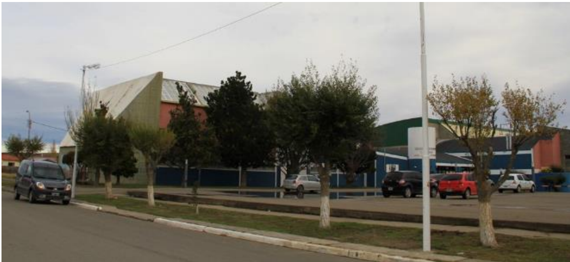
Figura -201. Polideportivo Municipal, Puerto Santa Cruz
