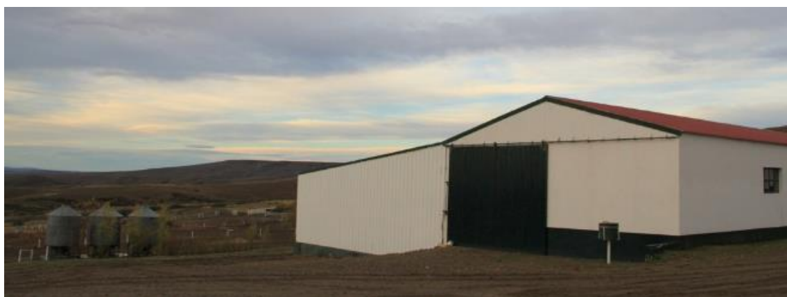
Figura -319. Galpón y Silos, Ea. San Ramón
